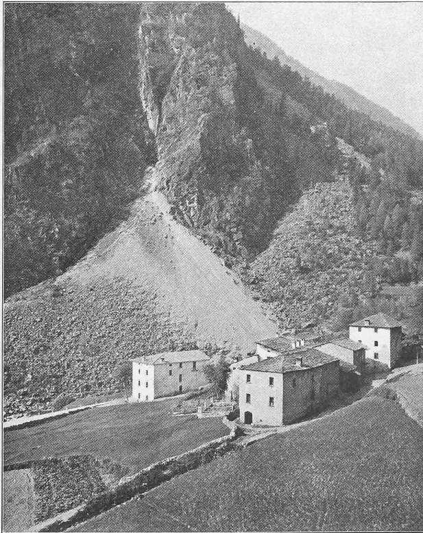
Abb. 11. Schutthalde bei Fenster Nr. 5.
