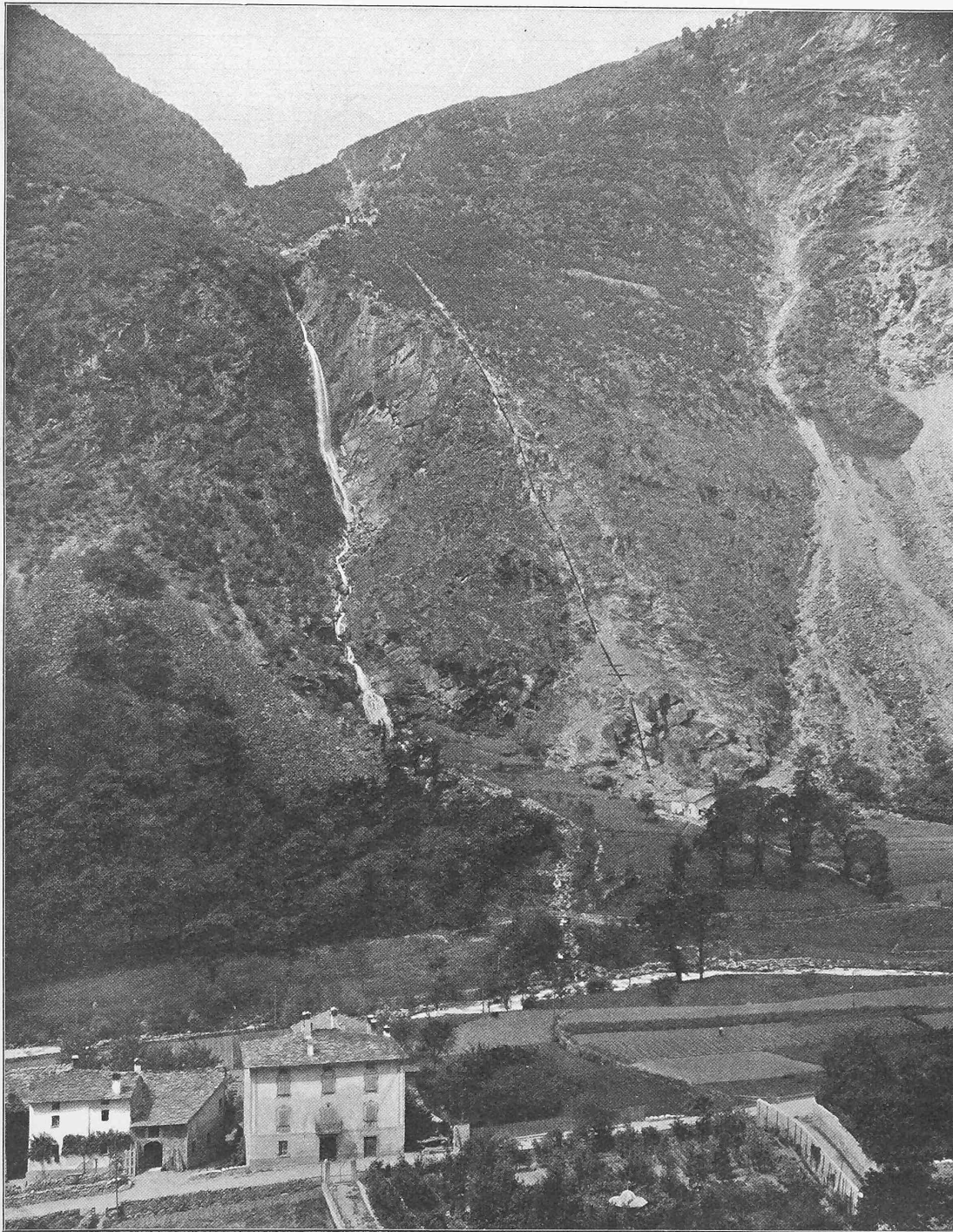
Abb. 13. Ansicht des Sajento-Kraftwerkes (Hilfszentrale).
