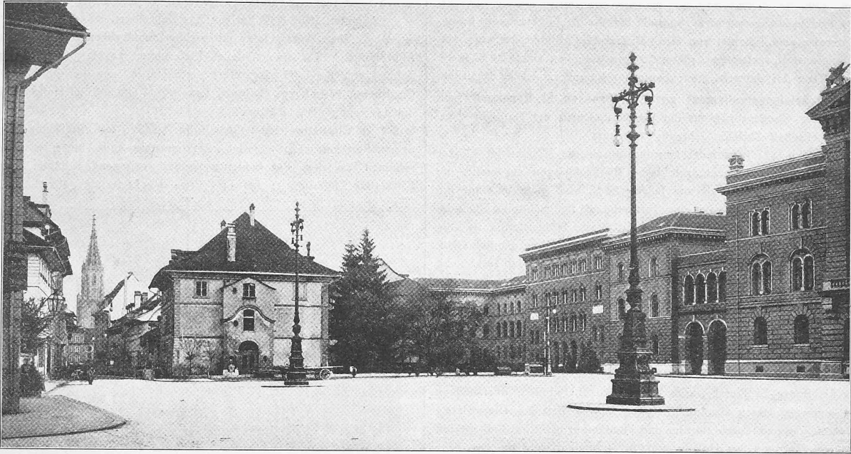
Ansicht des Bauplatzes von Punkt S des untenstehenden Lageplanes aus.
