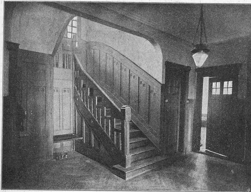
Abb. 4. Halle im Erdgeschoss des Landhauses «Bühlmatt».
