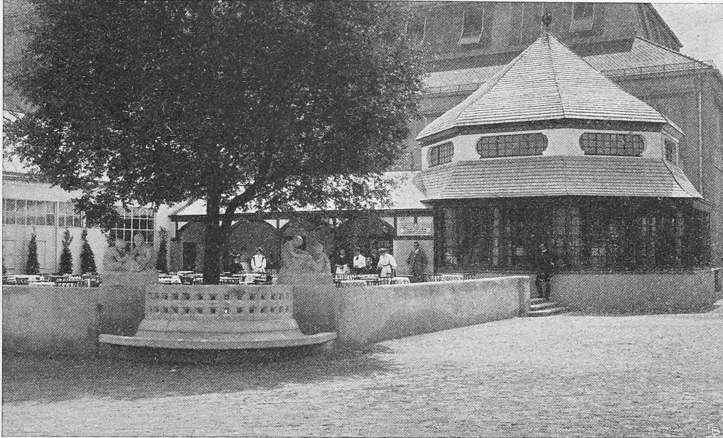
Abb. 7. Frühstückshalle. — Architekt: Richard Riemerschmid in München.
