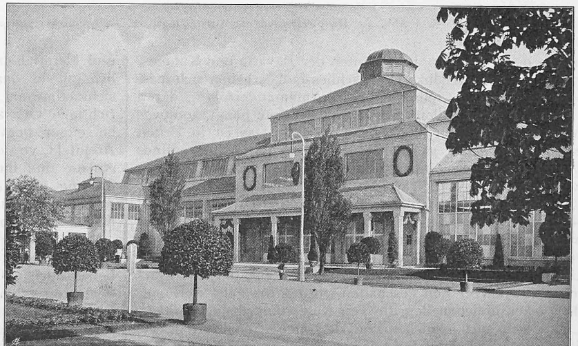
Abb. 6. Ausstellungshalle III. — Architekt: Wilhelm Bertsch in München.
