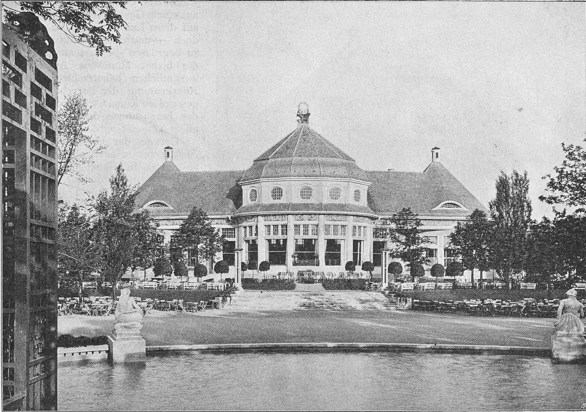
Abb. 4. Hauptrestaurant im Ausstellungspark. — Architekt: Emanuel von Seidl in München.
