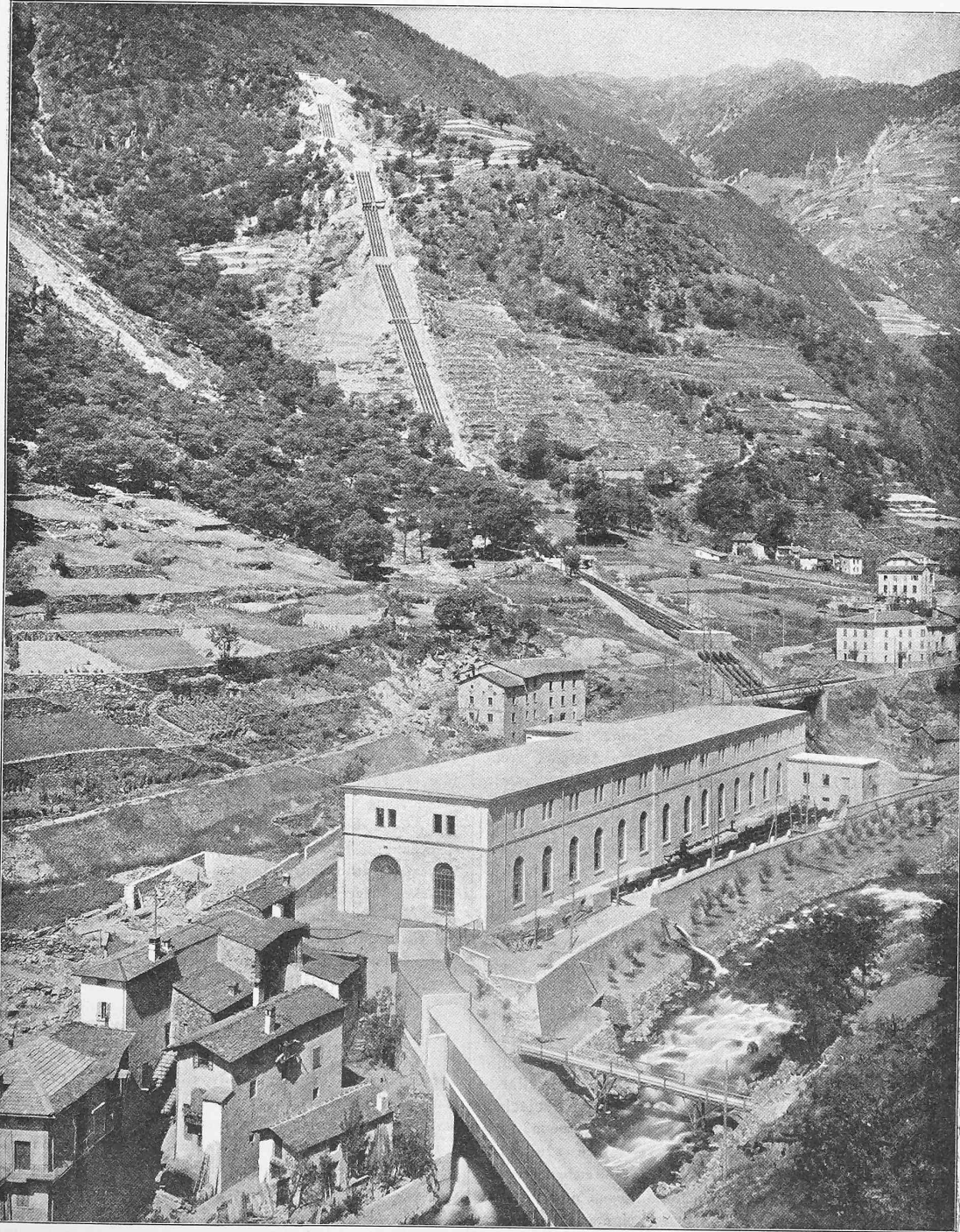
Abb. 28. Gesamtansicht des Kraftwerkes in Campocologno.
