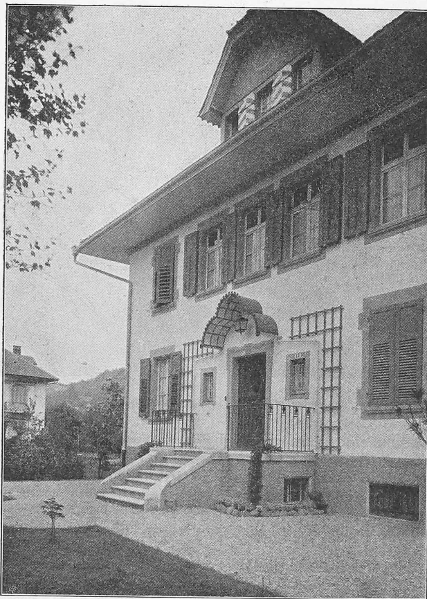
Abb. 8. Ansicht von der Strassenseite.
