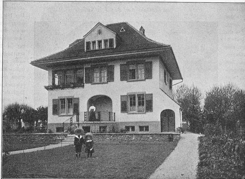
Abb. 7. Gartenansicht des Einfamilienwohnhauses in Thun.
