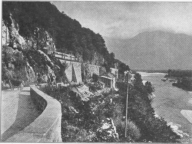
Abb. 4. Ansicht der Bahn unterhalb Pontebrolla.
