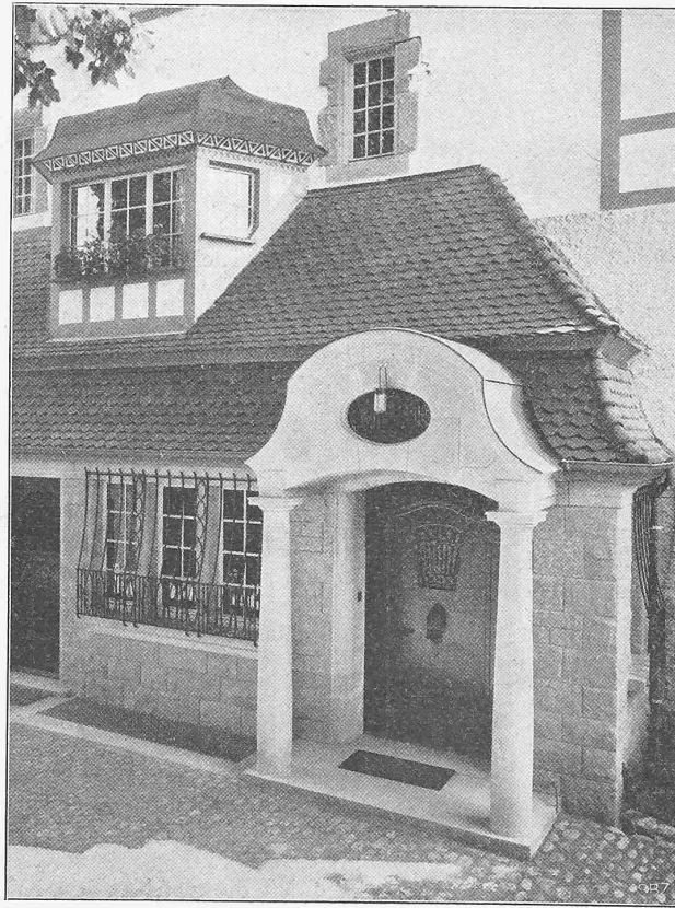
Abb. 6. Blick auf den Hauseingang.
