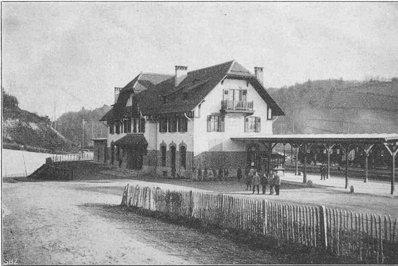
Abb. 3. Der neue Bahnhof der S. B. B. Puidoux-Chexbres. — Ansicht von der Vorderseite.
