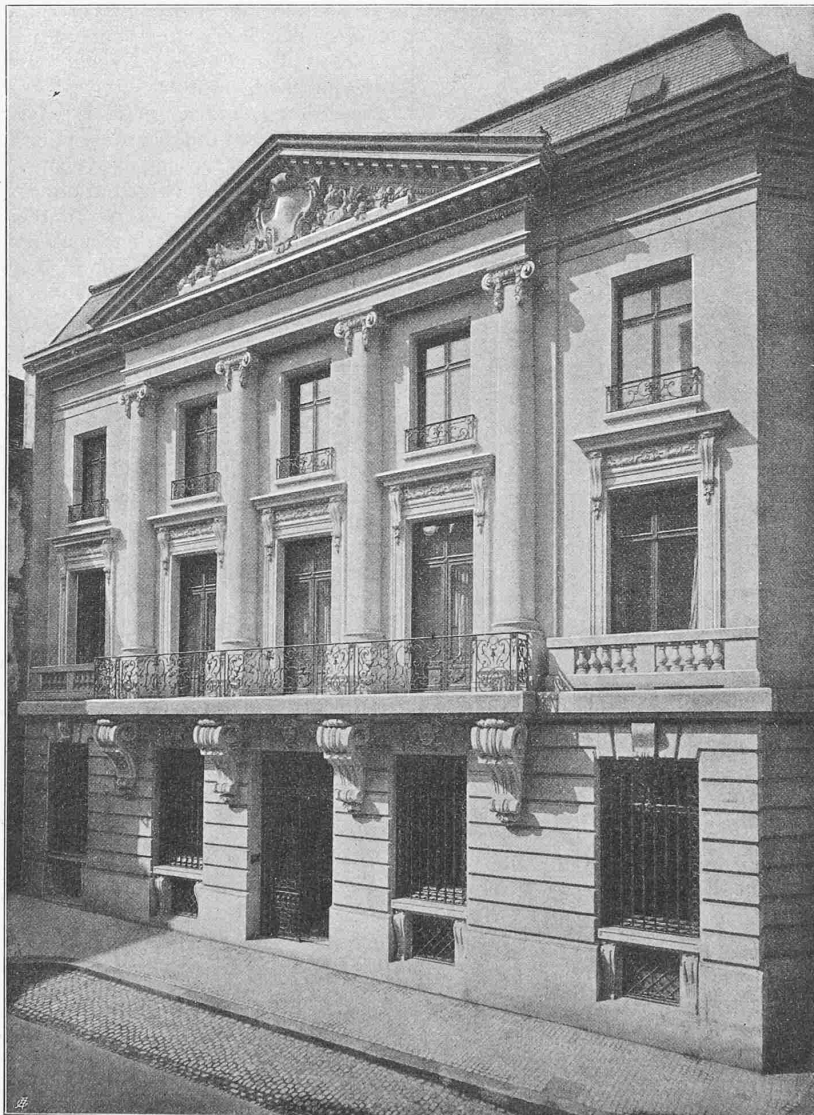
Abb. 5. Fassade an der Freienstrasse.
