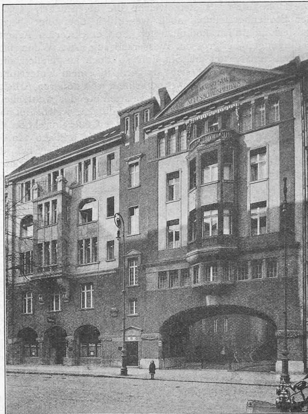
Abb. 7. Fassade des Verwaltungsgebäudes an der Nollendorfstrasse.
