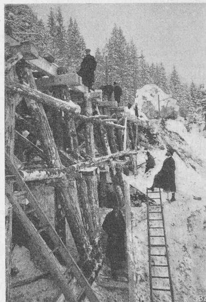
Abb. 4. Mittelloffnungen der Notbrücke.
