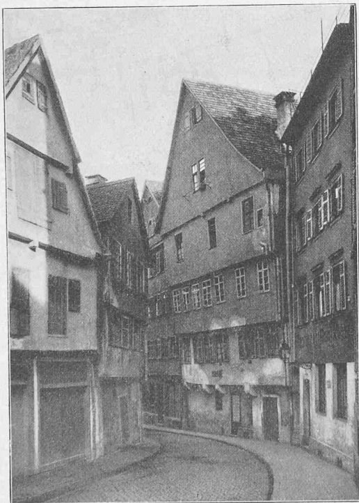
Abb. 2. Blick in die ehemalige Geisstrasse.
