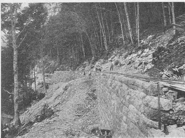
Abb. 35. Trockenmauer an der neuen Strasse (Juli 1907).
