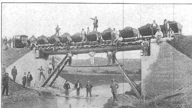
Bau der Kocherthal-Bahn (Württemberg).
