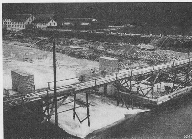
Abb. 13. Wehrschwelle I vollendet bei Mittelwasser. (15. November 1907.)
