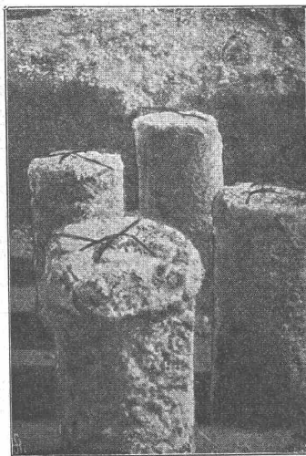
Simplexbetonpfähle
