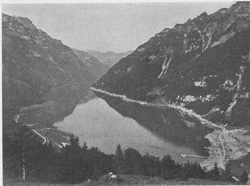
Ansicht des auf Kote 847 gestauten Klöntalersees.
