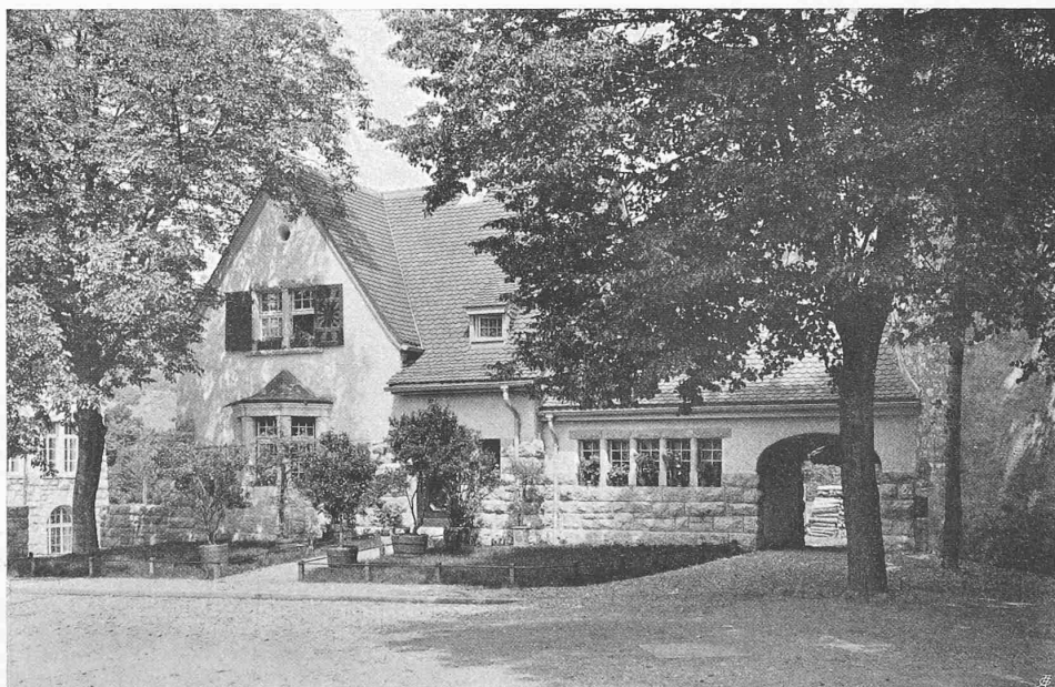
GEMEINDESCHULE BRUGG; ABWARTHÄUSCHEN VON SÜDOSTEN
