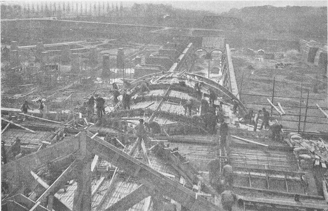
Abb. 25. Betonieren am Kreuzgewölbe, Blick gegen Süden auf den Zugangstunnel der künftigen Geleise-Perrons.
