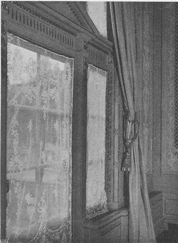
Abb. 32. Fensterheizung im Burgerratssaal des Berner Kasino.
