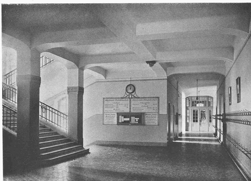
Treppenhaus und Vorplatz im Erdgeschoss des Südflügels
