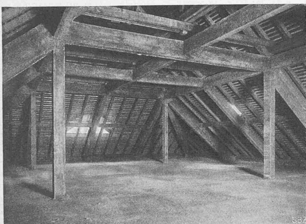
Abb. 6. Innenansicht der Dachkonstruktion, Magazin II.
