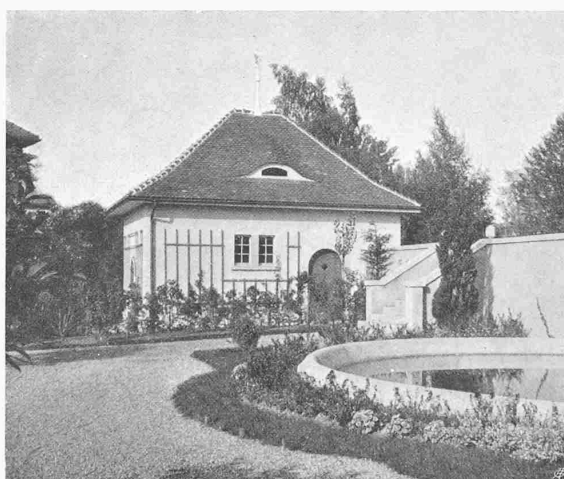
Gesamtbild und Garage
