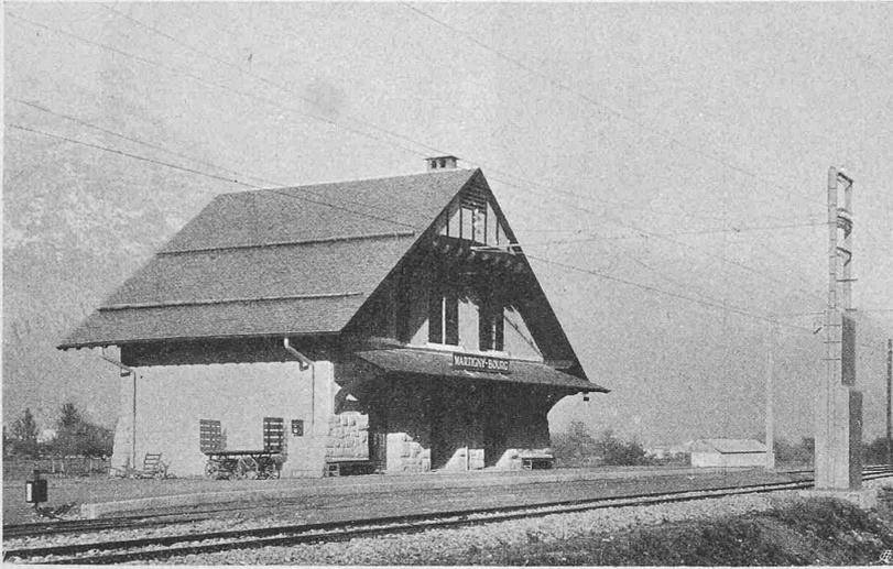
Abb. 10. Kontaktleitungen und Signalkabine auf der Station Martigny-Bourg.
