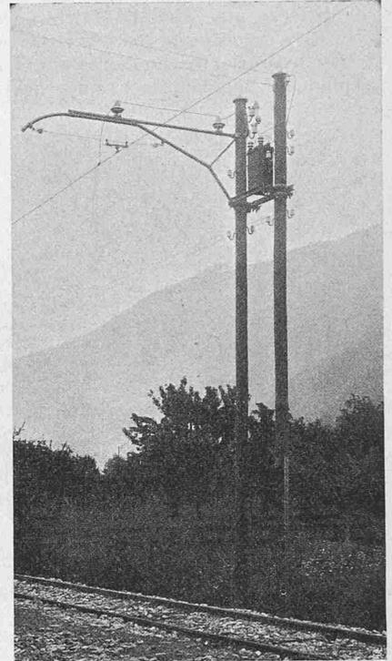
Abb. 12. Kleiner Beleuchtungstransformator.
