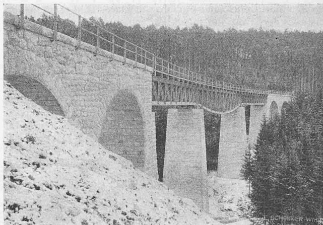
Abb. 9. Geissloch-Viadukt, von S.-W. gesehen.
