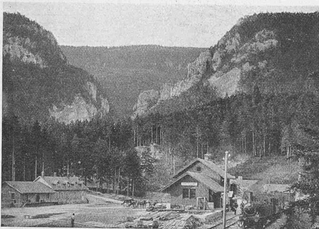
Abb. 6. Station Oberdorf am Südportal des Weissensteintunnels.
