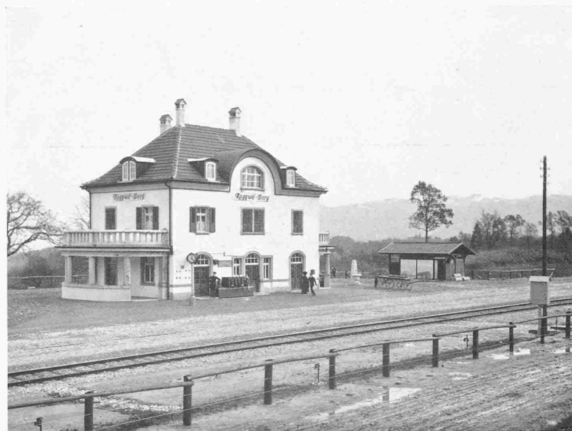
AUFNAHME-GEBÄUDE ROGGWIL-BERG DER BODENSEE-TOGGENBURG-BAHN
