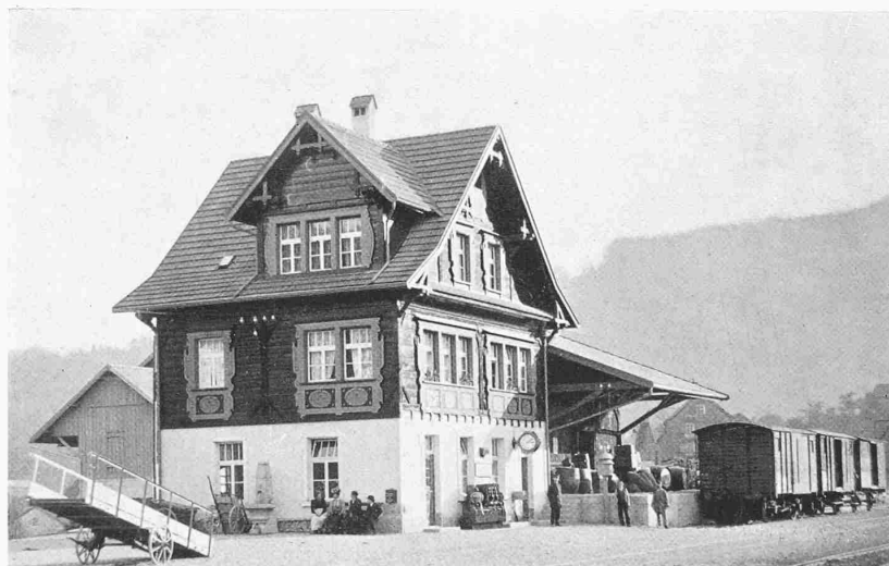
AUFNAHME-GEBÄUDE BRUNNADERN DER BODENSEE-TOGGENBURG-BAHN
