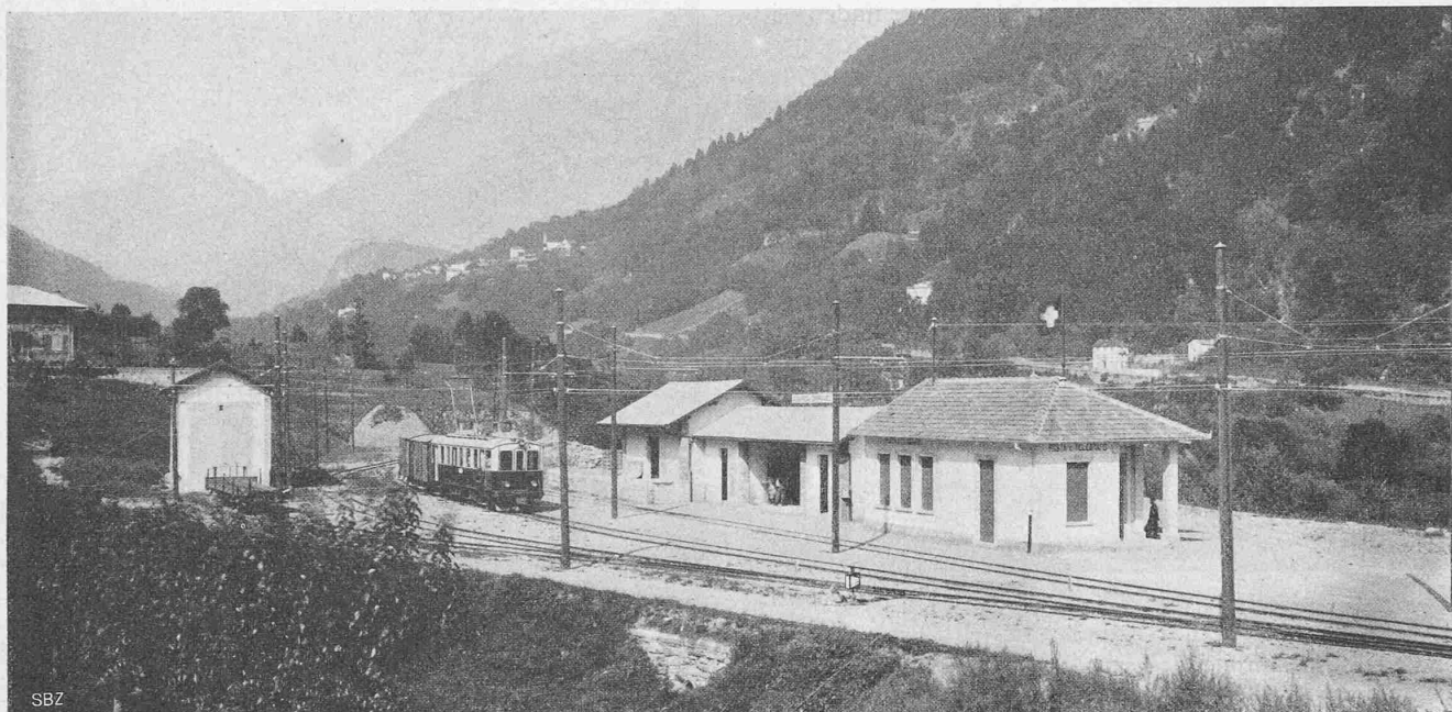
Abb. 10. Ansicht der Station Comprovasco (Acquarossa).
