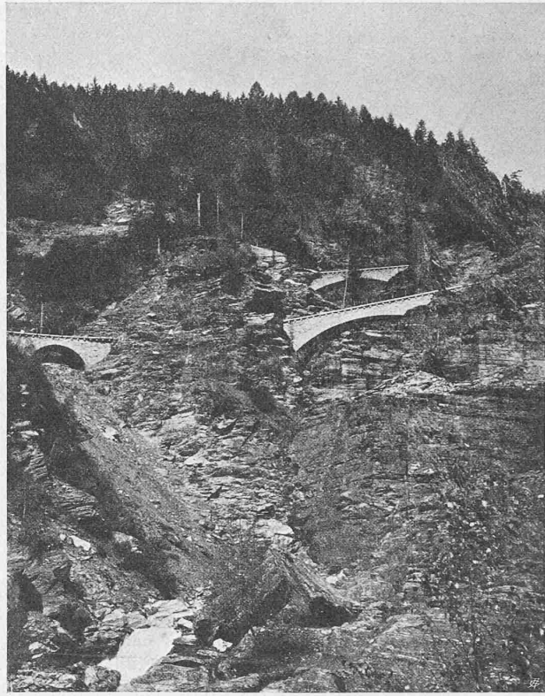
Abb. 20. Die Cavagliasco-Brücken oberhalb Robbia.
