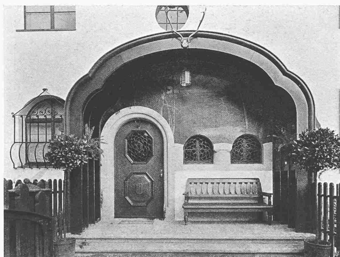
Ansicht von Westen und überdachter Hauseingang
