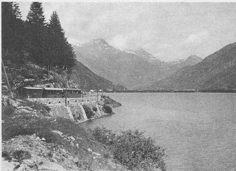
Abb. 31. Bahnkörper in der verbreiterten Strasse am Poschiavo-See.
