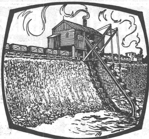
3 Löffelbagger } z. Zeit in der Schweiz 2 Eimerkettenbagger } im Betrieb.
