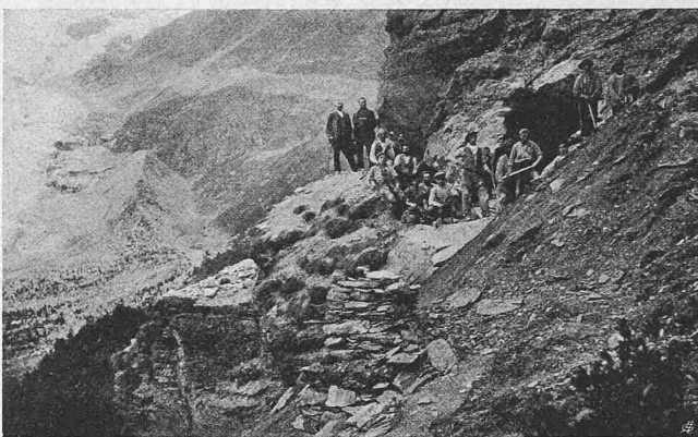
Abb. 43. Untere Stollenmündung des Palü-Tunnels (Km 28,125).
