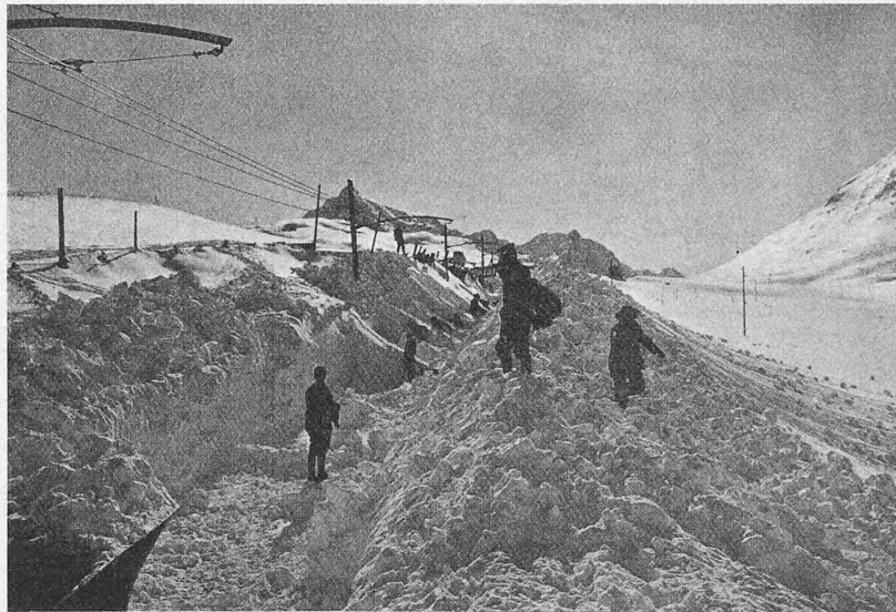
Abb. 57. Schneeräumungsarbeiten im ersten Betriebsjahr.
