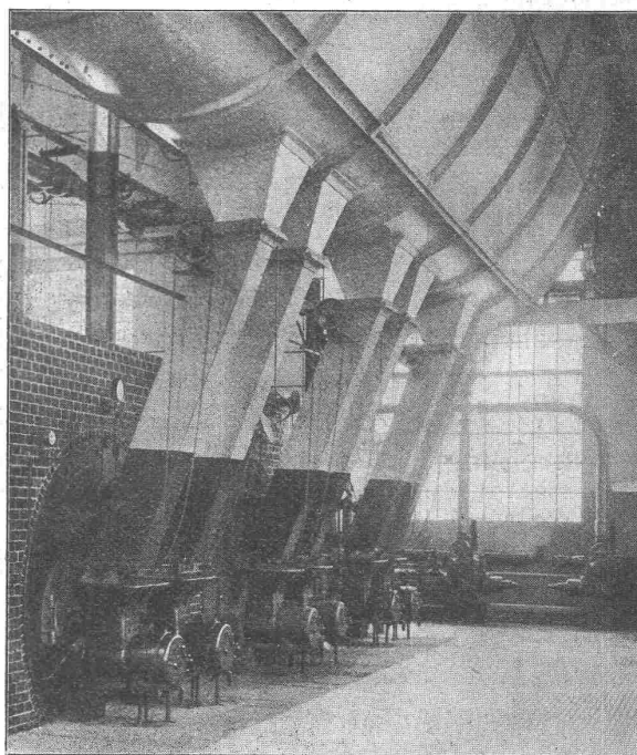
Kesselhausanlage „Hoffmann-La Roche“, Grenzach.
