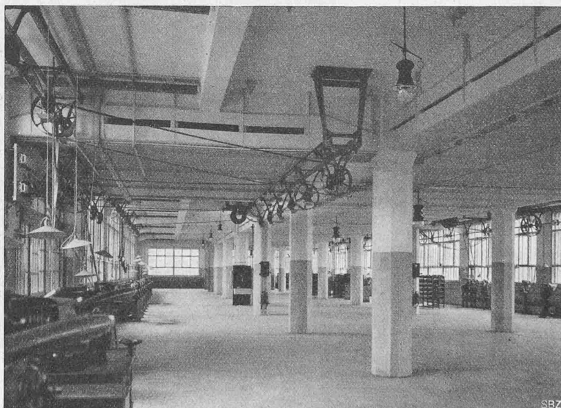
Abb. 20. Arbeitsaal im II. Stock mit Staubabsaugung und Frischluft-Zuführung.
