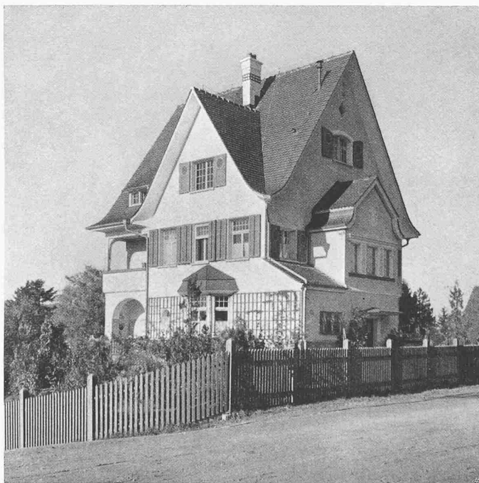
EINFAMILIENHAUS BEIM WANGENSBACH IN KÜSNACHT ARCHITEKT STADTBAUMEISTER M. MÜLLER, ST. GALLEN
