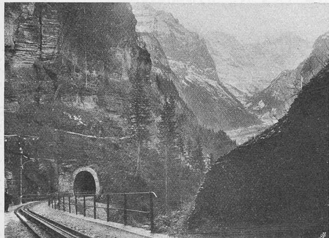
Abb. 7. Blick talwärts von Km. 2,0 aus.
