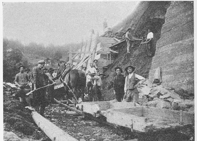
Abb. 10 u. 11. Materialtransport durch Schlitten.
