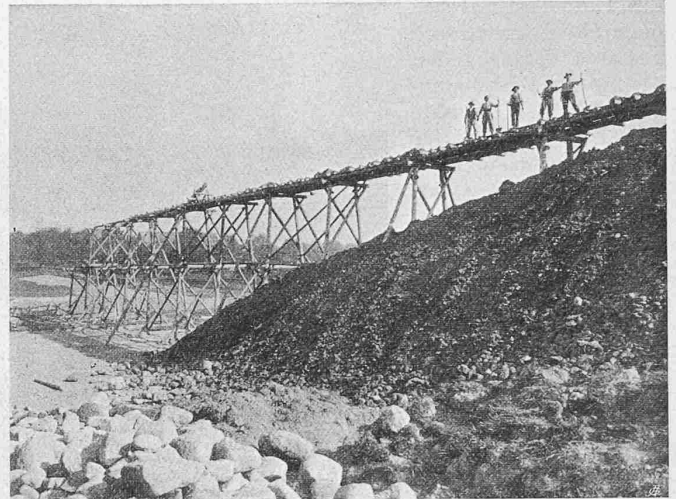
Abb. 8. Vom Bau des Dammes bei Hohenbühl.
