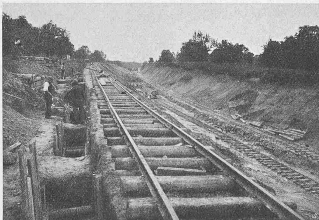
Abb. 3. Parallel-Sickerung im Einschnitt Neukirch-Egnach.
