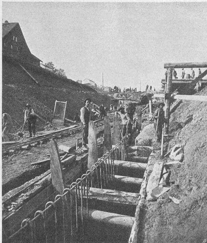
Abb. 15. Verlängerung des Taltunnels bei Herisau.
