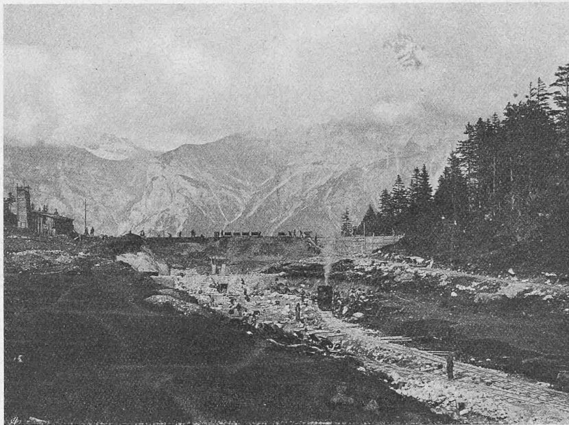
Abb. 17. Vertiefung der Weihersohle gegen den Ostdamm hin.
