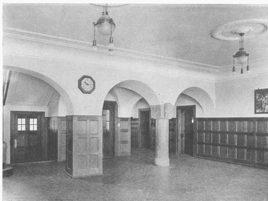
Halle im Erdgeschoss
