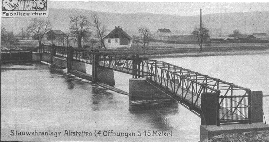
Stauwehranlage Altstetten (4 Öffnungen à 15 Meter)
