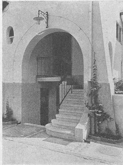
Abb. 6. Nordwestecke mit Nebeneingang.
