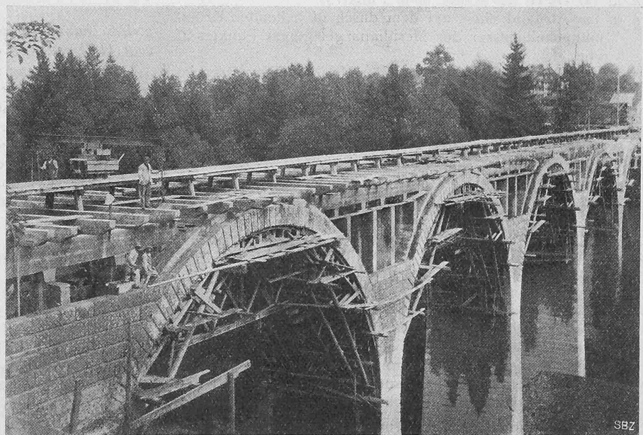
Abb. 9. Aufmauern der Verkleidungswände, Versetzen der Siegwartbalken. 3. IX. 1912.
