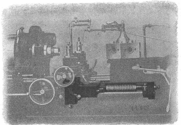
An den grossen Loewe'schen Revolverbänken kann der neuartige oben dargestellte **Gewindeschneid-Apparat** am **Quersupport** angebracht werden, welcher zur raschen Herstellung genauer Innen- und Aussengewinde mittelst Leitspindel dient. Der Rückzug des Gewindestahls am Ende und die Anstellung am Anfang des erzeugten Gewindes wird durch eine Spezialeinrichtung erleichtert.
