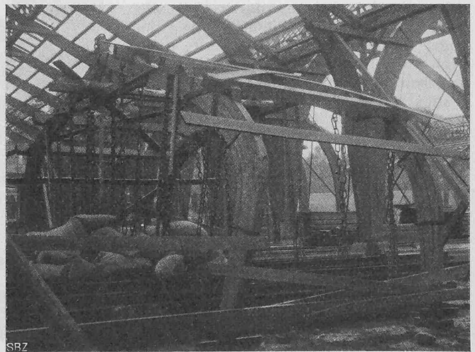
Abb. 14. Vorn links Binder I, hinten rechts Binder II.
