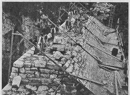
Abb. 13. Mauerung der Wehrkrone.
