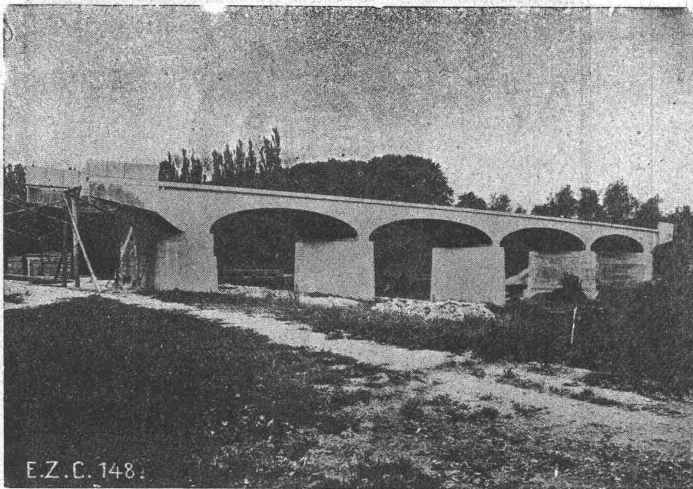
Brücke über die Ergolz für die Zufahrtstrasse zum Kraftwerk Augst-Wylen bei Augst. — Kontinuierlicher Balken mit variablem Trägheitsmoment aus massiven Pfeilern. — Ausgeführt 1908.
